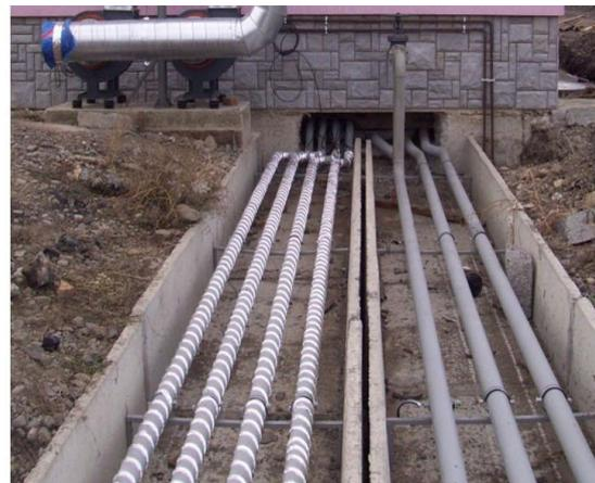
Система электрического обогрева, предназначенная для уменьшения вязкости масла в трубопроводах и резервуарах, с целью предотвращения закупоривания, кристаллизации вещества и чрезмерного сгущения нефтепродуктов.
