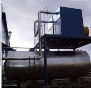
Поставлена задача на прогрев емкости и трубопроводов до +15 градусов при наружной температуре -30 градусов. Особенность системы в том, что при рабочем процессе жидкость закачивается в емкость после охлаждения, который собирает ее при температуре +80 градусов и охлаждает до +15. Фактически поддерживать заданную температуру необходимо только при остановке тех. процесса.
