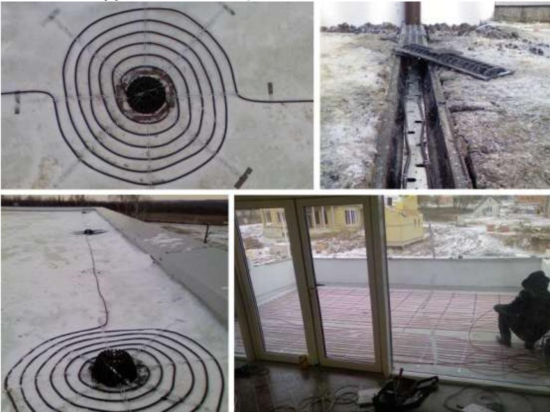
Необходимо обеспечить водоотвод талой воды с плоской крыши, а также обеспечить подогрев балконного этажа для стаивания снега.
